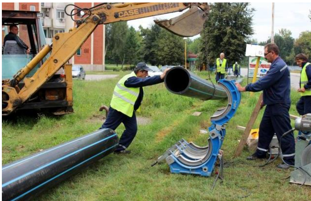
Реконструкција магистралног цевовода за водоснабдевање Јагодине (17.06.2015. Танјуг)
