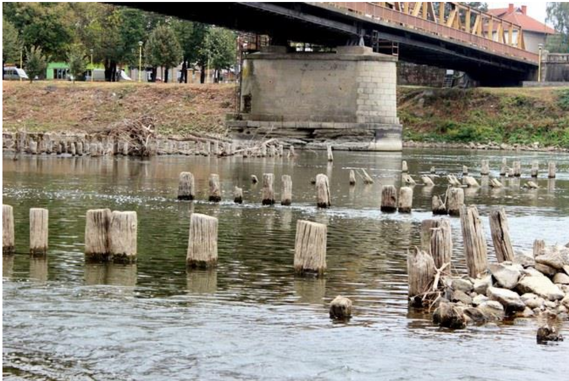
Велика Морава код Ђуприје - изронили дрвени стубови моста из времена под Османлијама, август 2019 (Фото Танјуг – Д. Аничих).
