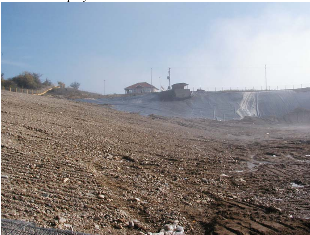
Slika dno deponije sa postavljanjem folije
