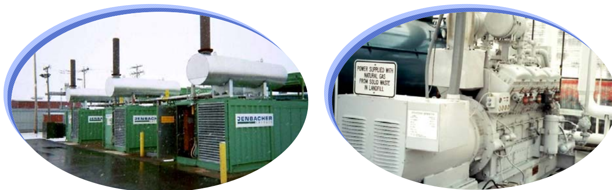
Slika 15. Sagorevanje deponijskog gasa
